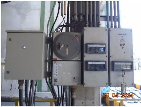
ภาพที่ 2.1-32 ตู้ Panel แบบป้องกันการเกิดประกายไฟ
