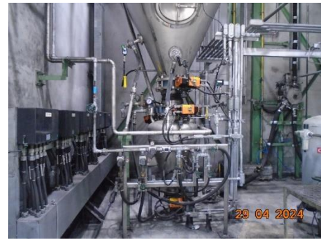
ภาพที่ 2.1-2 ระบบกักเก็บและป้องกันการฟุ้งกระจายของคาร์บอนแบล็ค
