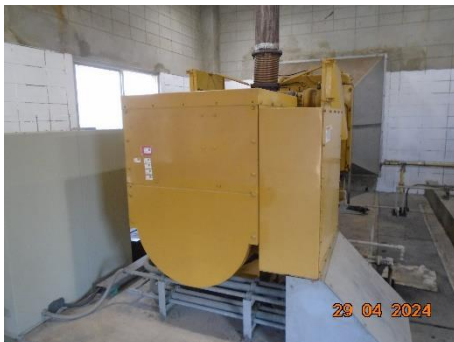
ภาพที่ 2.1-28 ระบบไฟฟ้าสำรอง (Diesel Generator)
