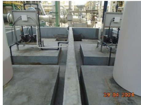
ภาพที่ 2.1-37 รางระบายบริเวณสถานที่เก็บสารเคมี
