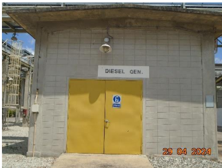
ภาพที่ 2.1-3 การปิดคลุมแหล่งกำเนิดเสียง
