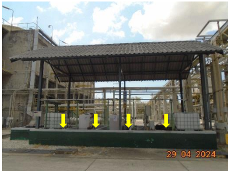
ภาพที่ 2.1-36 คันกั้น (Dike) กักเก็บสารเคมี
